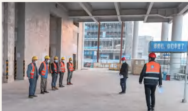
▲ 国盛大厦项目复工。
